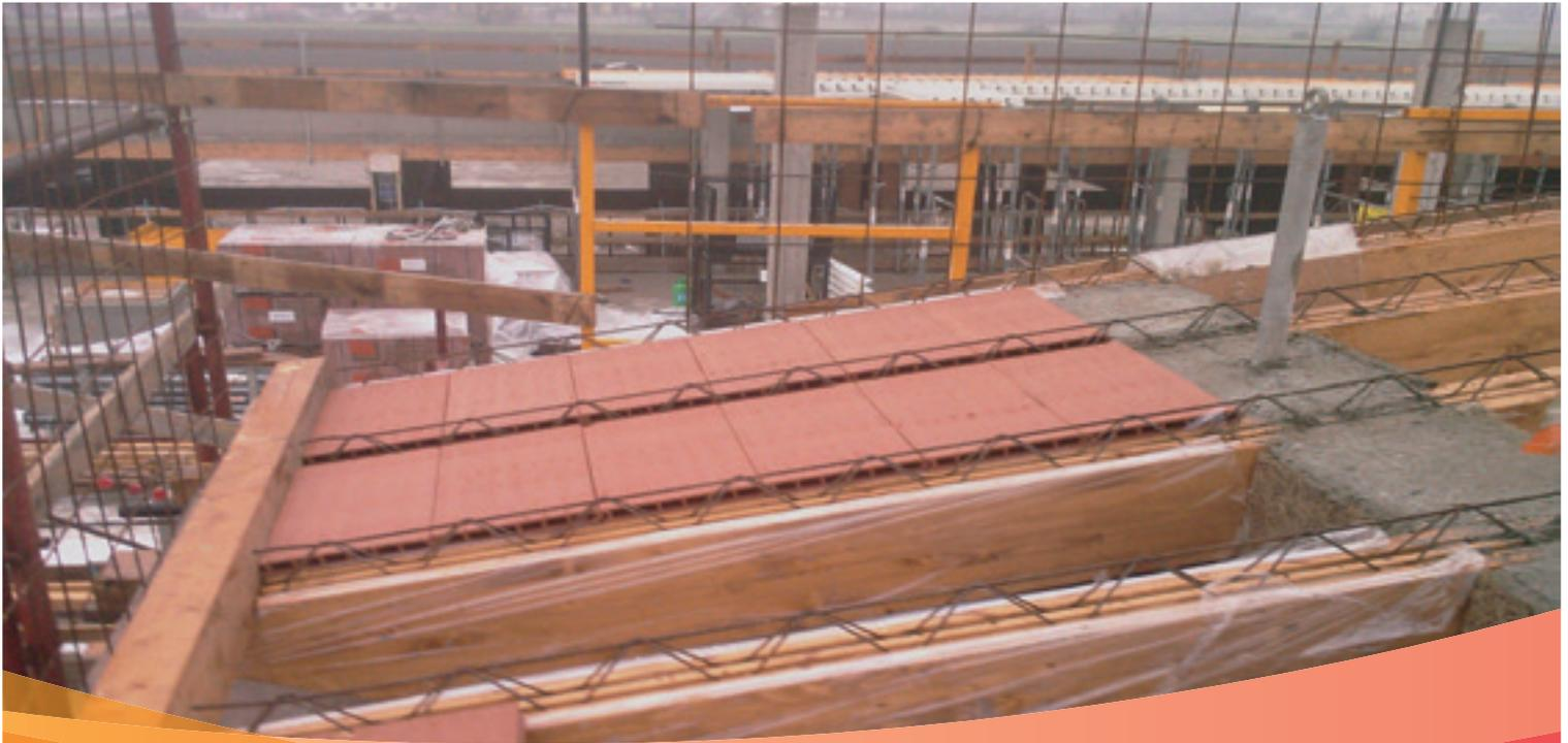
**Solai di copertura su telaio in c.a.**
