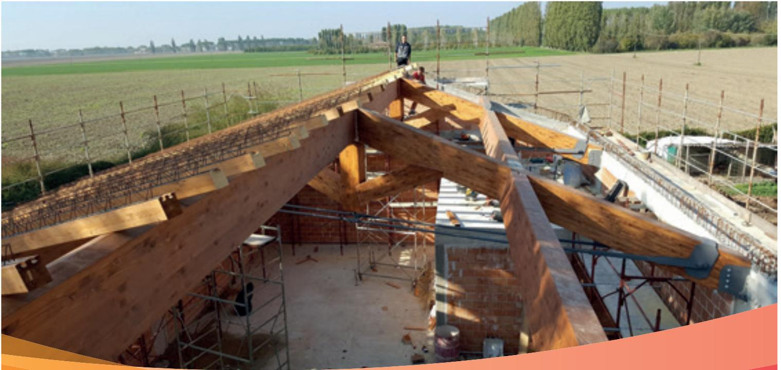
**Solai di copertura su telaio in legno**
